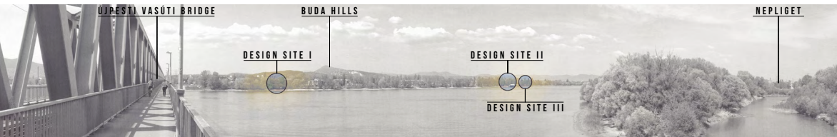
UJPESTI VASÚTI BRIDGE
